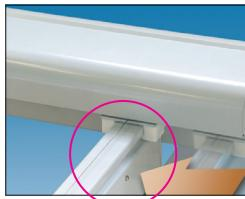
En général, les composants mécaniques ne demandent presque pas d'entretien. Un graissage occasionnel des pièces en mouvement (chariot de la barre de chute etc.) à l'aide d'un lubrifiant approprié (spray de silicone) ainsi qu'un contrôle / entretien périodique par une entreprise spécialisée STOBAG sont recommandés afin de prolonger la durée de vie du système de toit en verre et du store intégré.
