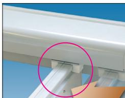
In het algemeen moeten de mechanische onderdelen niet vaak worden onderhouden. Het wordt aanbevolen de bewegelijke delen (kunststoffglijders etc.) af en toe met een geschikt smeermiddel (siliconenspray) te smeren en periodieke inspecties/opknapbeurten door een STOBAG specialist uit te laten voeren. Dit zal de levensduur van het glasdakssysteem en de zonwering verlengen.
